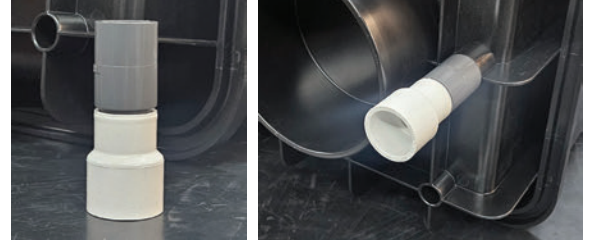
Image 11 Gluing conduit adapter
