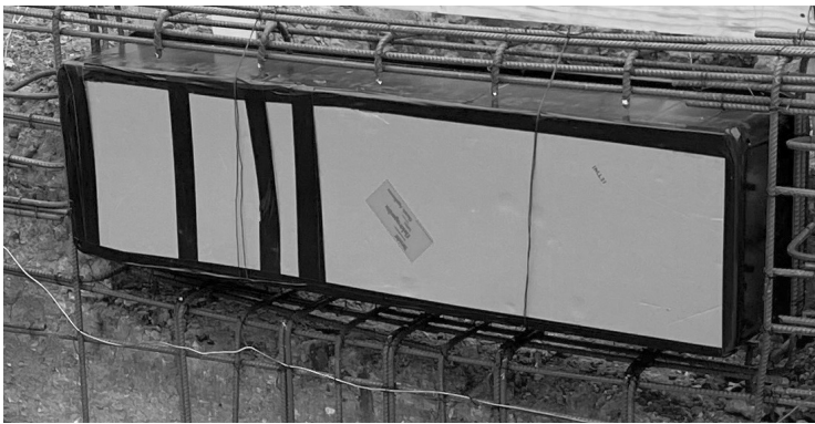
Image 4 BaduJet Turbo Pro - Jet placement in rebar
